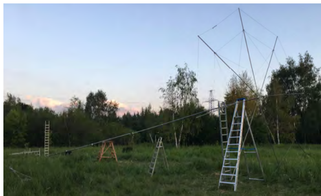
Рис. 14. Антенна собрана, заземлители забиты, «юбочка заземления» развёрнута, падающая стрела установлена, оттяжки растянуты и закреплены к подъёмным кольям. Можно поднимать. Но уже темнеет.
